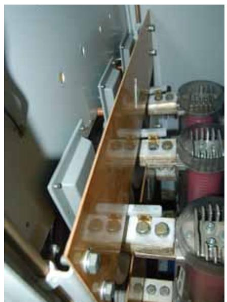
Рисунок 6. Вариант установки датчиков ТЕРМО-В в составе КРУ
